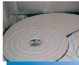
Pose du sol de la douche hélicoïdale. Sur chantier, chacun des éléments doit uniquement être assemblé et collé.
