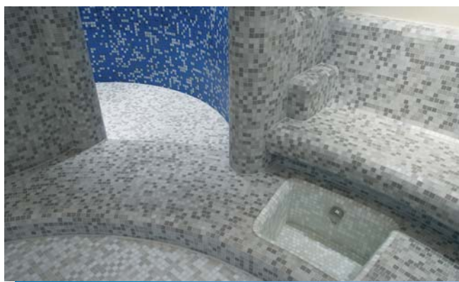
... après achèvement des travaux. À l'arrière-plan, un siège de repos chauffant également paré d'éléments porteurs en mousse dure.
