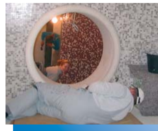
Le hublot pendant la pose de carreaux de mosaïque en verre.
