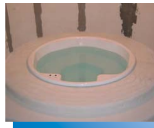
La baignoire balnéo préfabriquée en usine, livrée avec une estrade, est intégrée avec précision au chantier.
