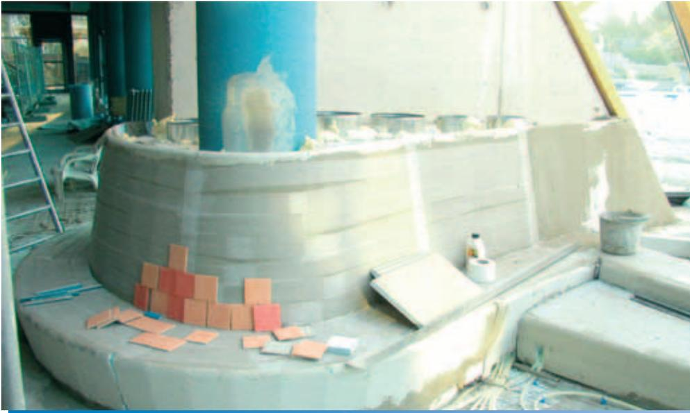
Les matériaux de constructions résistants à l'eau mis en œuvre pour les marches et banquettes courbes sont des éléments porteurs en mousse dure compatibles avec l'environnement et fabriqués par Lux Éléments.
