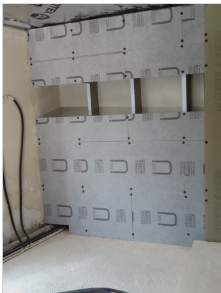
■ Pour l'espace douche, les panneaux prêts à carrelier et pré-étanchéifiés en usine furent posés sur une ossature.
