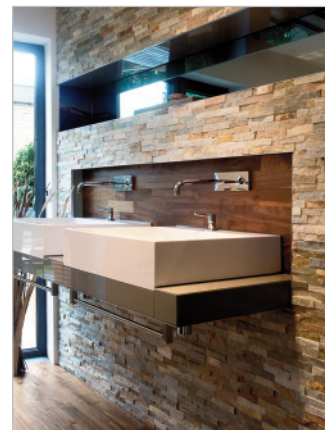
■ Travaux terminés – les vasques design blanches en marbre moulé forment un joli contraste avec la pierre naturelle de la cloison de séparation.
