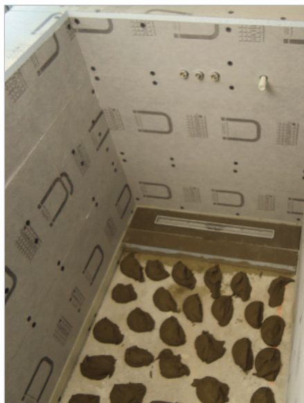
■ La douche à fleur de sol avec écoulement en ligne est réalisée avec des éléments de pente selon la technique du « collage par plots ».
