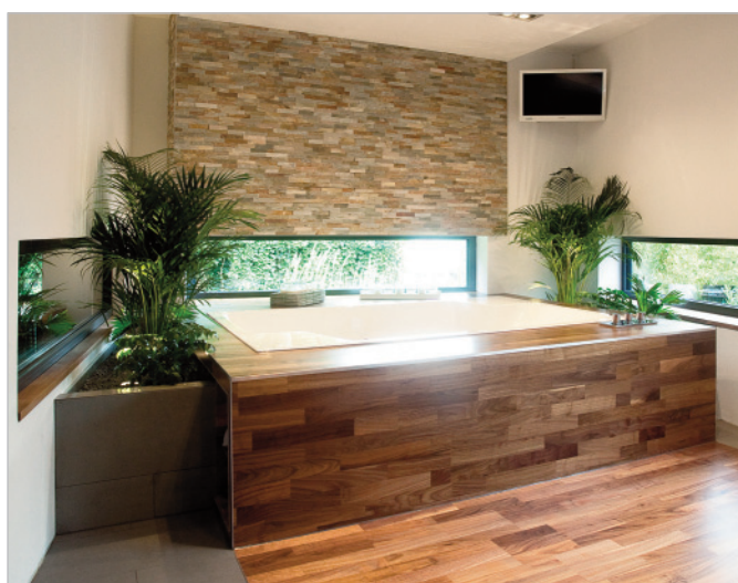
■ Travaux terminés – la baignoire est délimitée par trois parois et revêtue d'un noble parquet en bois de noyer.
