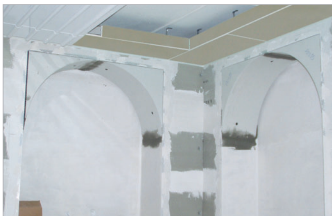
■ ... die Rundbögen über den zugemauerten Fenster und ...
