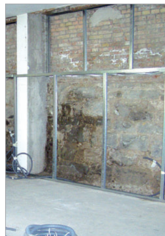
■ Arbeitsbeginn: Vor das feuchte Mauerwerk wurde zunächst das Ständerwerk montiert.
